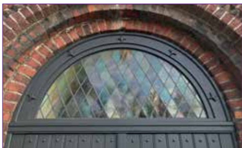
Türfenster im Haupteingang der Gnadenkirche
